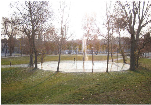
Vista della vasca-stagio da nord
