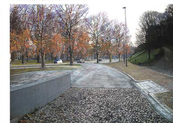
Vista Via Portanuova e confluenza uscita parcheggio
